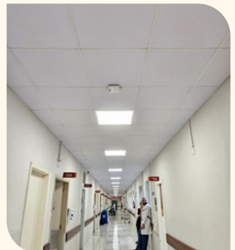
Melhorias de sinalização e iluminação no Hospital Cajuru
